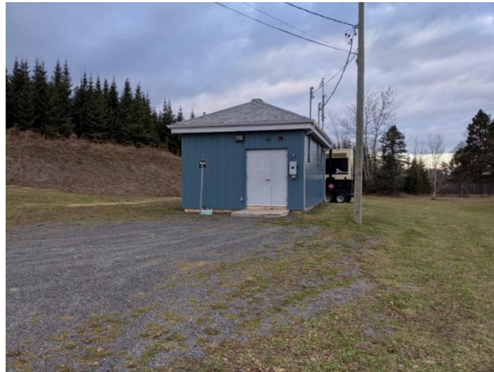
Figure 3 : Photo du site et du bâtiment de services - novembre 2020
