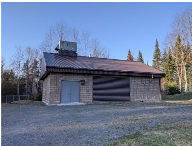
Figure 4 : Bâtiment de services du Puits P-4 – novembre 2020
