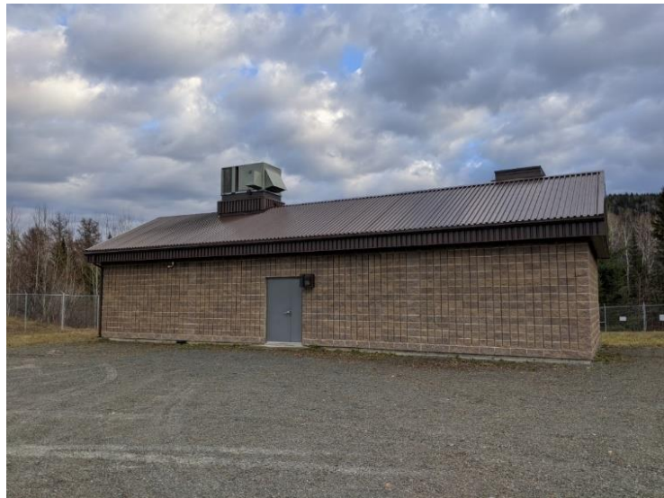
Figure 1 : Photo bâtiment de services du puits P-3 - novembre 2020
